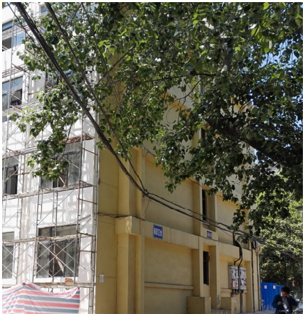
校园内现状通信线
