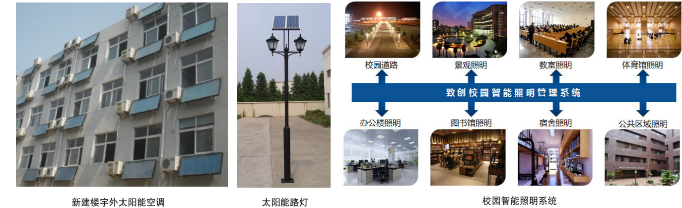
新建楼宇外太阳能空调
